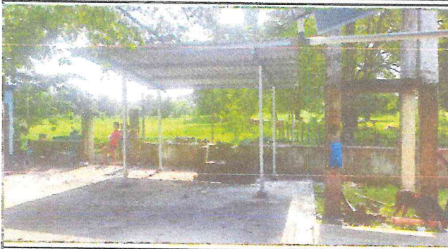
Foto 7: Estructura y techo de galera
